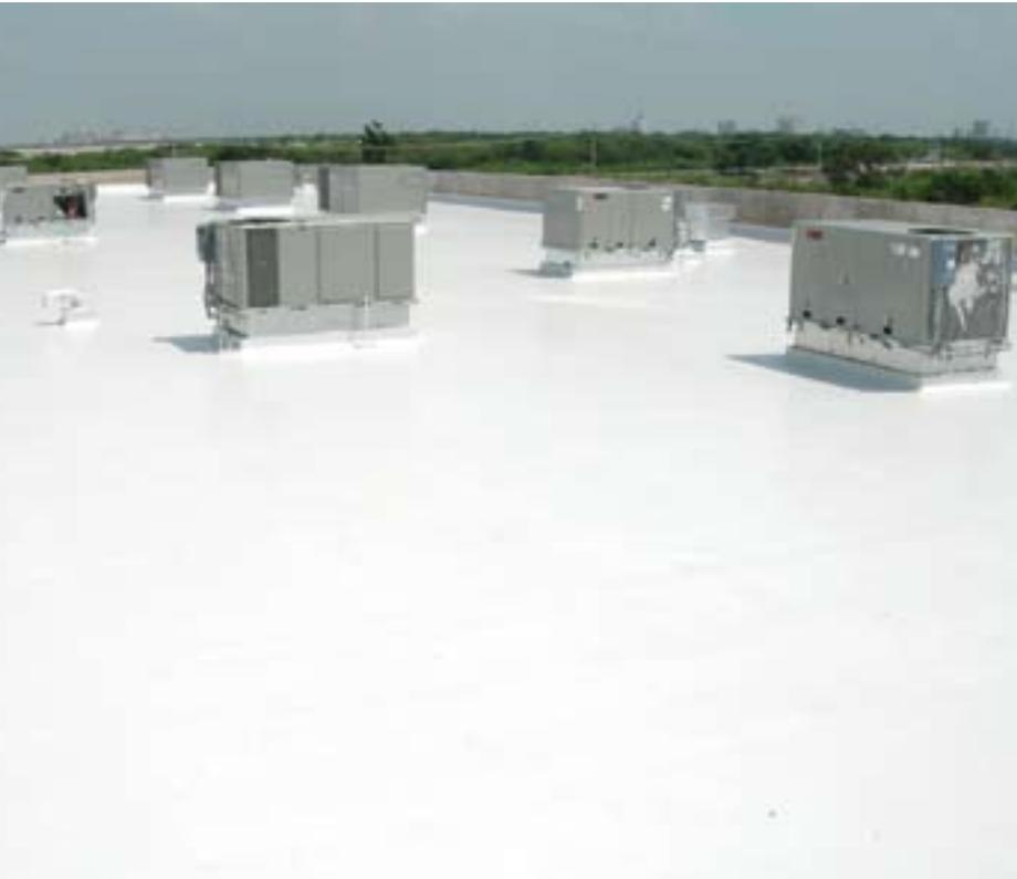
El sistema **AL-FLEX<sup>PRO</sup>** es altamente reflectivo produciendo que la superficie baje su temperatura y que su transferencia de calor al interior de las construcciones sea menor, logrando reducir el uso de aire acondicionado y ahorrando en consumo de energía eléctrica. Por esa razón **AL-FLEX<sup>PRO</sup>** es un material reconocido y avalado a nivel mundial por
